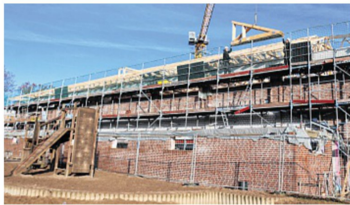
Im November 2016 wurden die Dachsparren auf die neue Sporthalle gesetzt.
